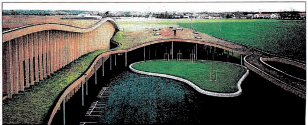
Soprema est un spécialiste de la végétalisation des toits. Ici, le collège Froehlicher de Sissonne (Aisne) sur lequel l'agence rémoise a travaillé.
